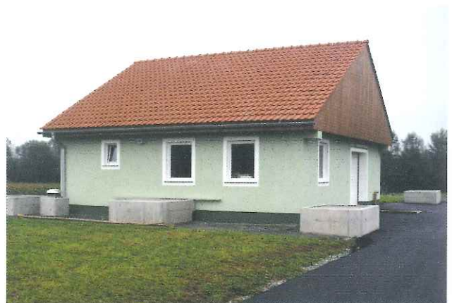
Kläranlagengebäude in Klein Pöls, 2014
