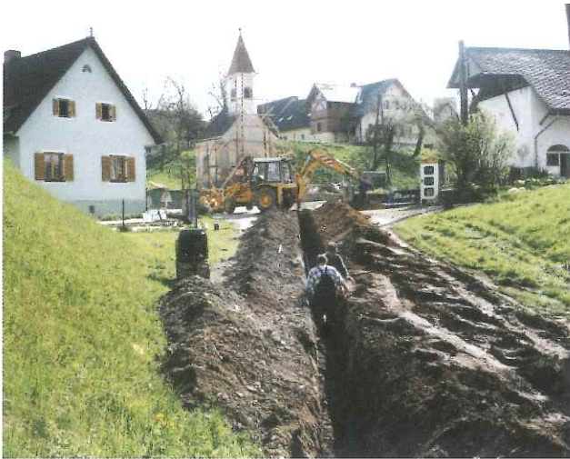
Wasserleitungsbau in Steindorf, 1997
